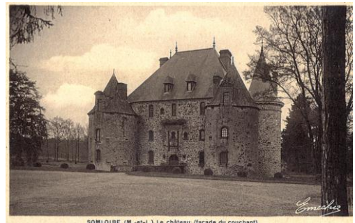
SOMLOIRE (M.-et-L.) Le château (façade du couchant)
